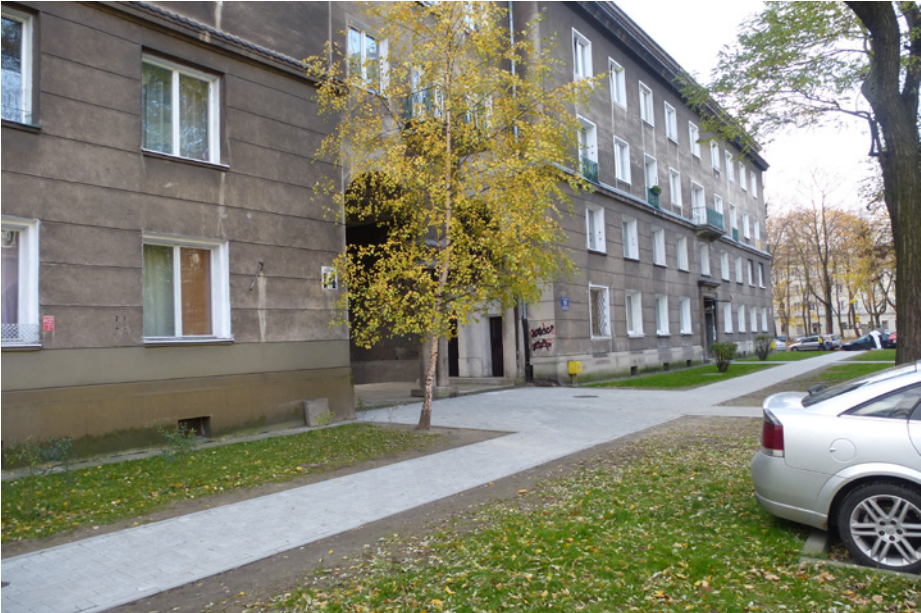
Wyremontowany chodnik na os. Stalowym 14
