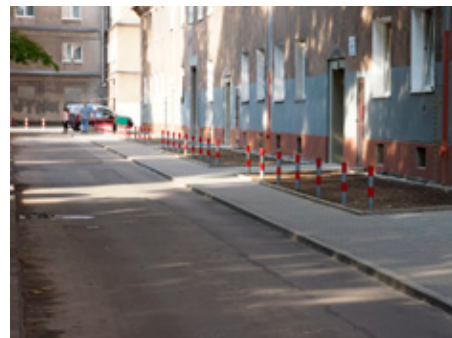
wyremontowany chodnik na os. Centrum C
