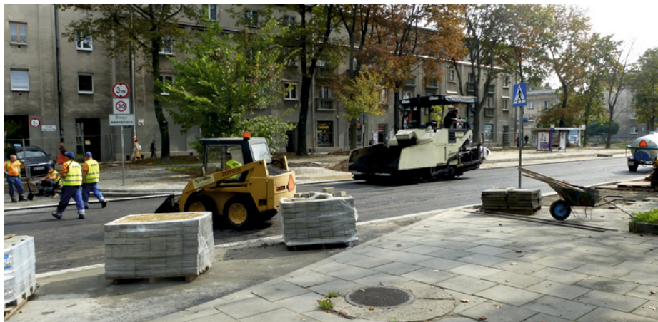
ul. Obrońców Krzyża podczas remontu
