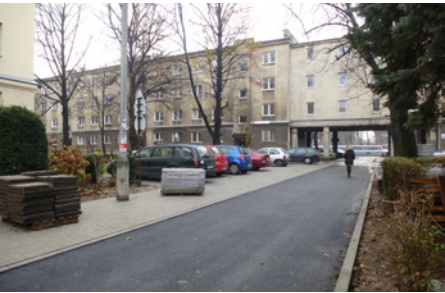
os. Ogrodowe nowa nawierzchnia jezdni i miejsca postojowe
