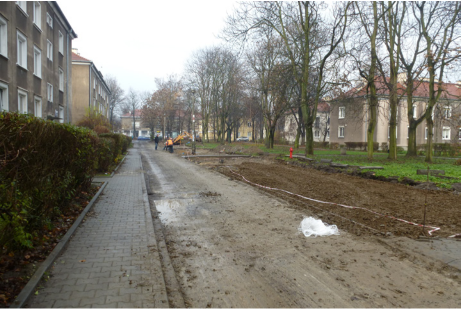
os. Wandy remont nawierzchni jezdni i miejsc parkingowych wraz z remontem chodnika
