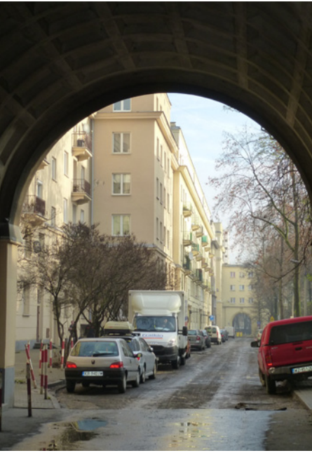
os. Stalowe remont nakładki asfaltowej jezdni
